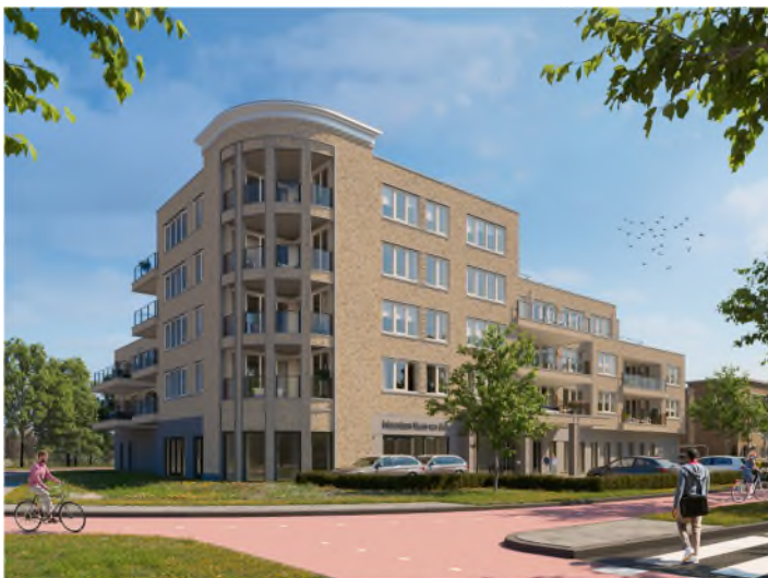
Figuur 4. Vooraanzicht appartementencomplex
